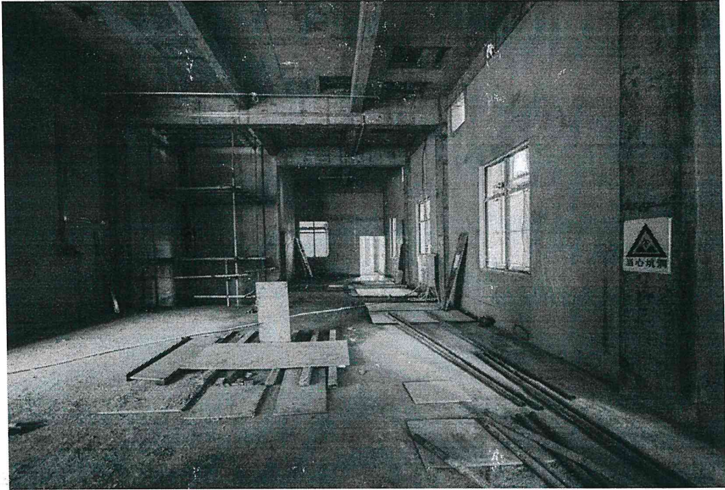
图 2:2025 年 6 月 13 日, 2#原粮清理车间 2 层吴*兰坠落现场
